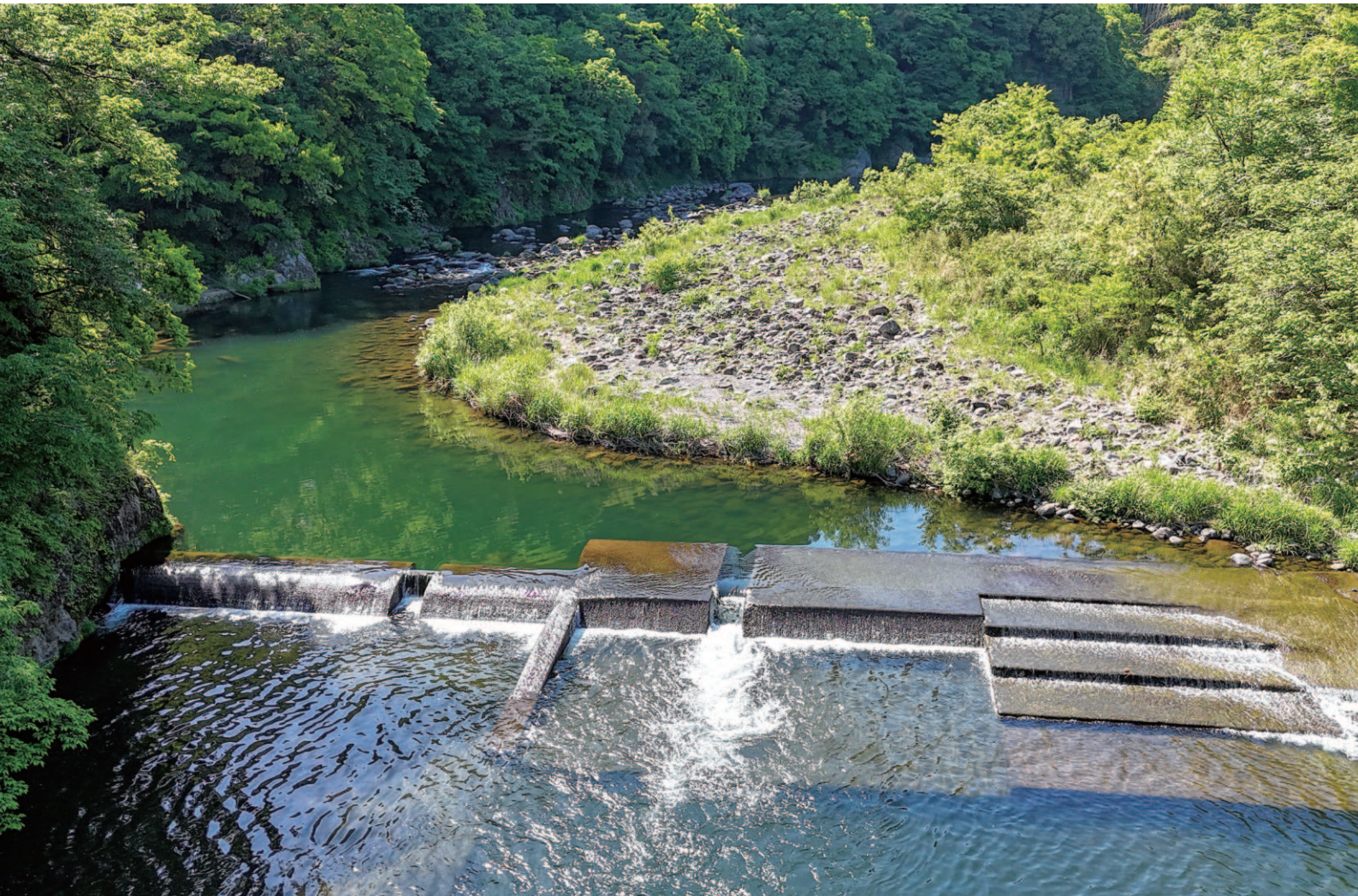
渡良瀬川揚水機場堰堤
