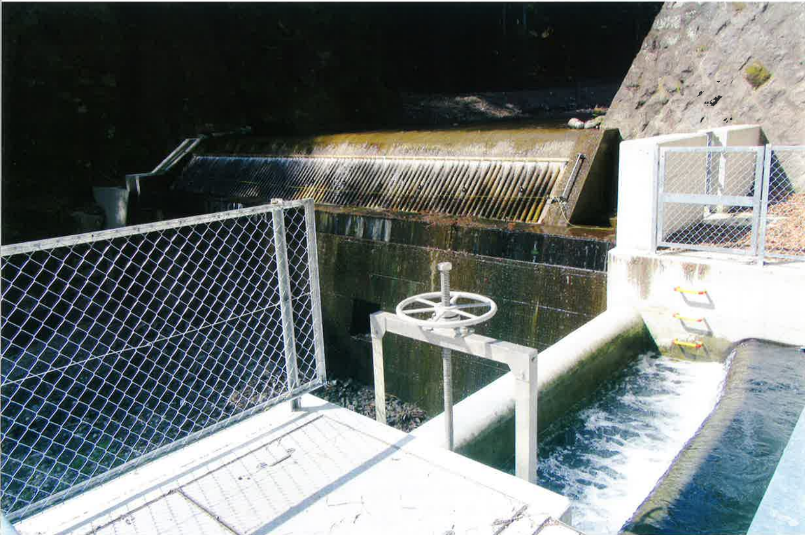
～令和2年度改修工事が終了し新しくなった深沢頭首工～
