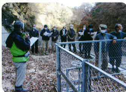
新しくなった深沢川頭首工
