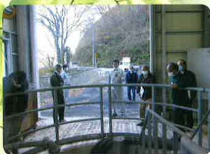
渡良瀬川揚水機場ポンプ室
