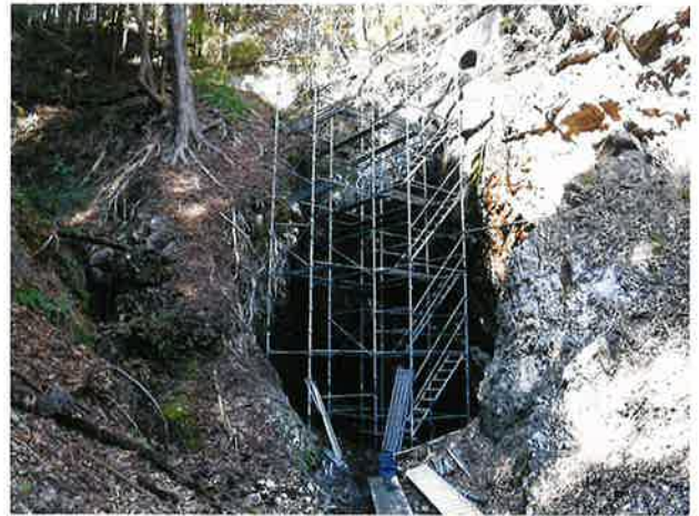
8号隧道出口改修工事中の状況(平成29年度)
