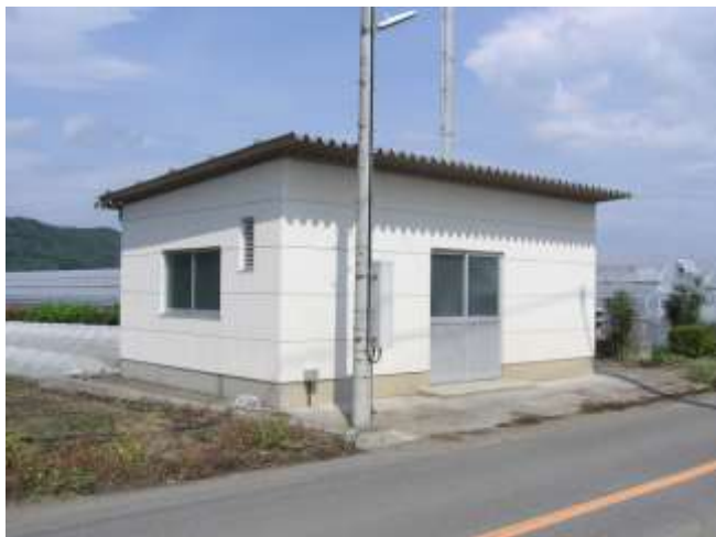
清水減圧弁室建屋
