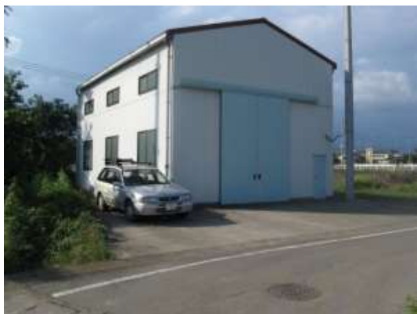
清水除塵機場建屋
