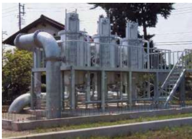
建屋着工前の清水除塵機
