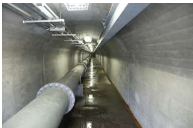
管理トンネル（横坑 57.5m 高さ 2.2m）
