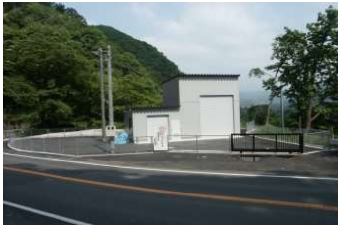
渡良瀬川用水機場操作室建物の全景
