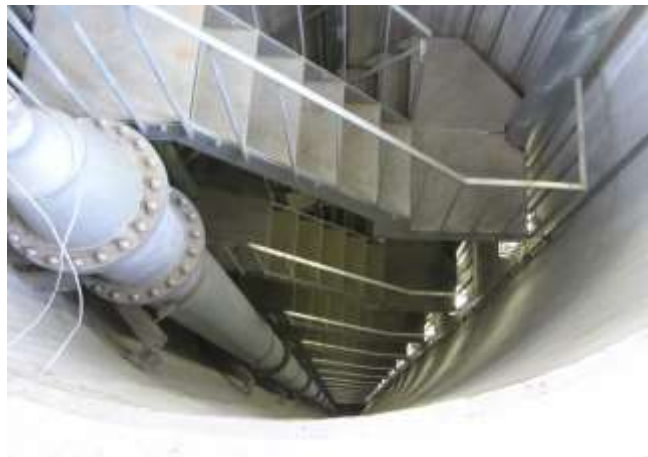
管理トンネル（立坑 50.0m 直径 3.0m）
