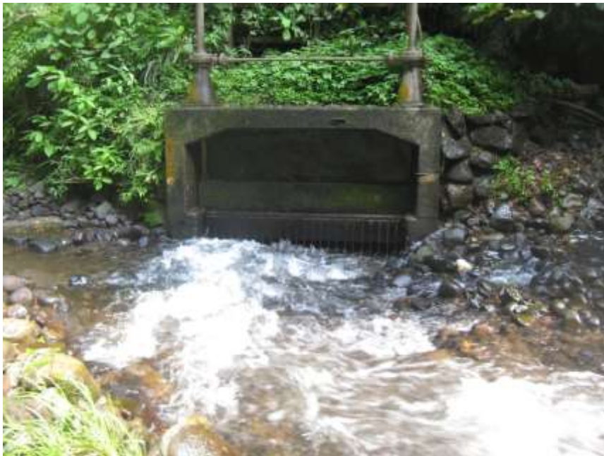
深沢川頭首工（平成24年7月撮影）
