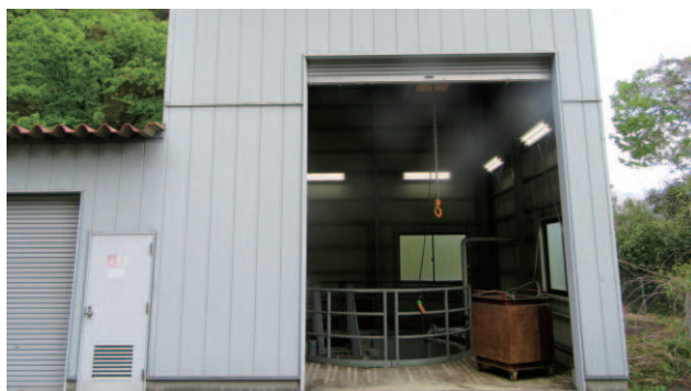
渡良瀬川揚水機場
