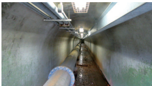
管理トンネル横坑 57.7m
