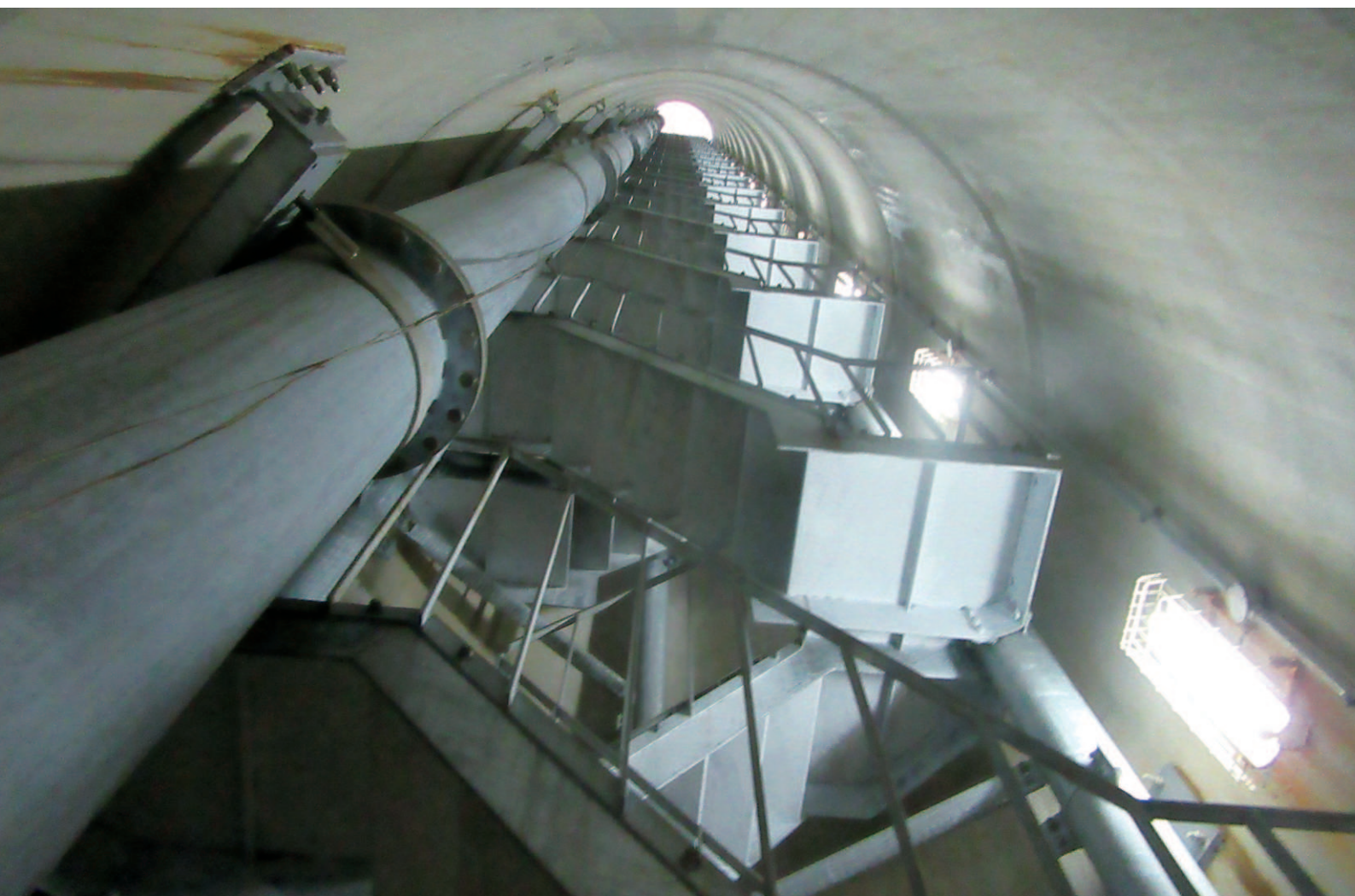
渡良瀬川揚水機場 (立坑 50.0m 最深部より撮影)
