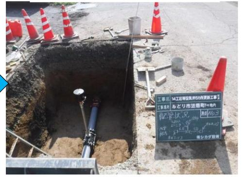
新しくなった空気弁の様子(更新工事中)
