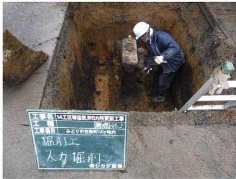
古くて錆び付いた空気弁の様子(更新工事中)
